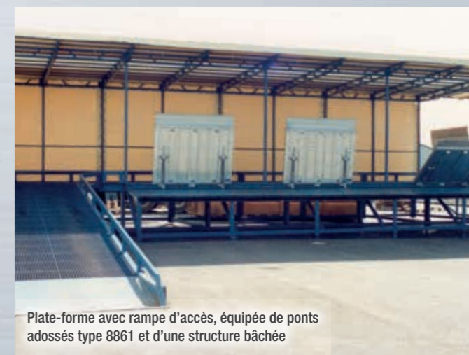
Plate-forme 8 x 8 m avec structure bâchée + 2 postes à quai (portes, niveleurs et sas)
